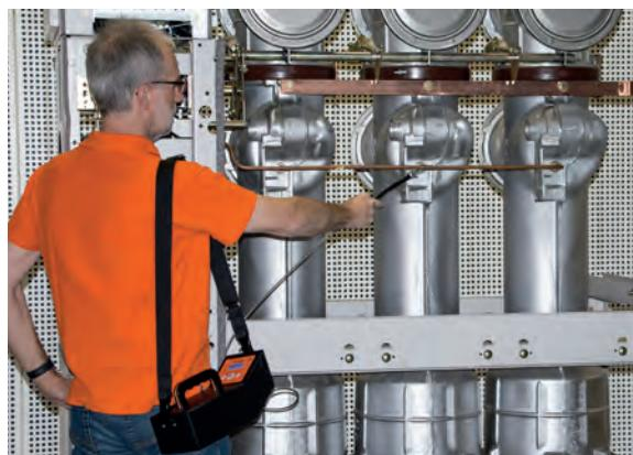
Расширение измерительного датчика (входит в комплект поставки) позволяет проводить измерения в измерительных точках, к которым трудно получить доступ.
